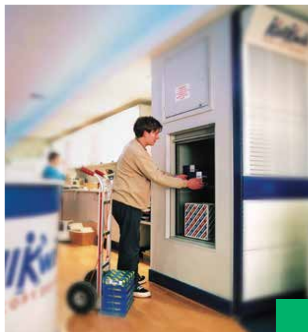
Installazione in una fotocopisteria (Inghilterra), modello 100 kg, cabina e porte in acciaio inox AISI 304.
