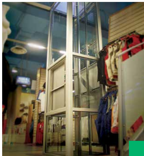
Installazione in un negozio di abbigliamento (Italia), modello 50 kg, rivestimento vano in vetro e cabina standard verniciata in RAL 7038.
