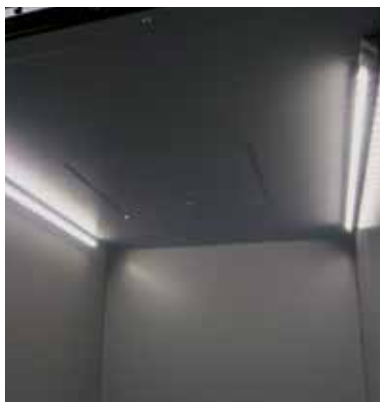
Illuminazione Cabina con barre LED
