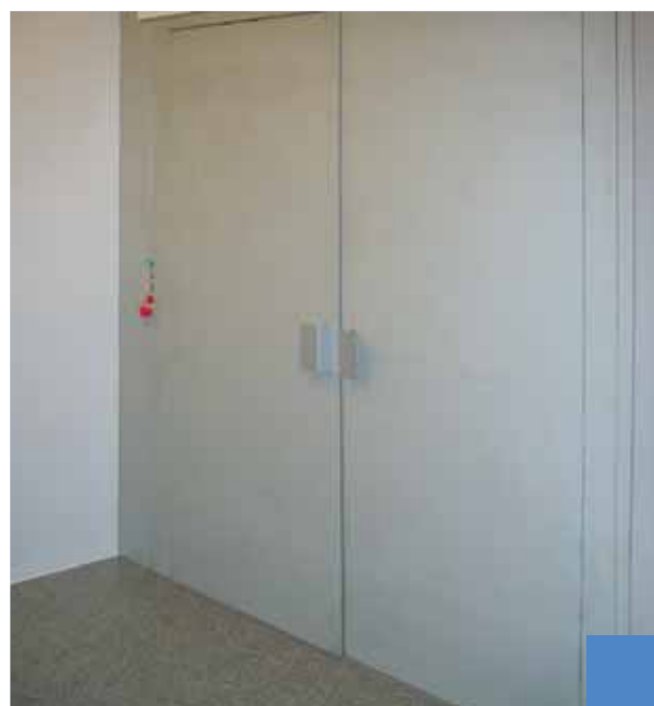
Installazione in un centro commerciale (Francia), modello 1000 kg, porta a doppio battente, pulsantiera stagna.
