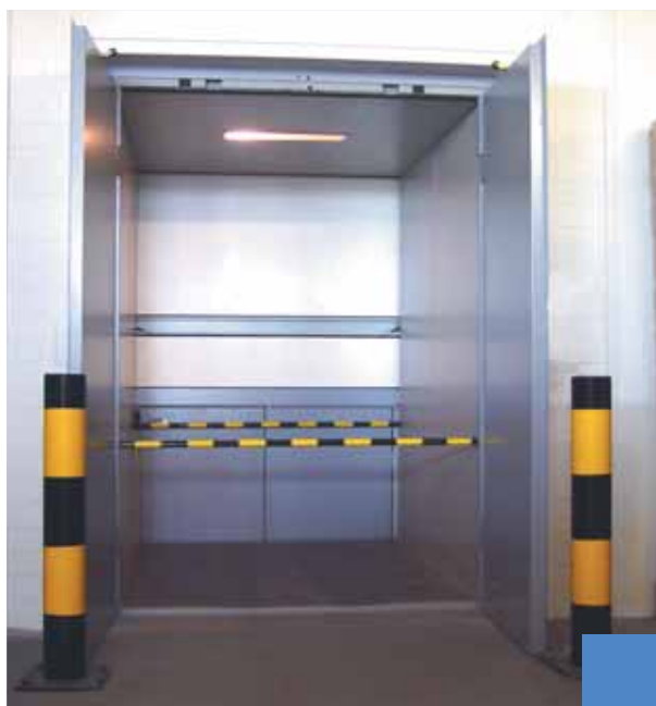
Installazione in un magazzino (Olanda), modello 1500 kg con finiture standard RAL 7038.
