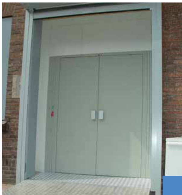
Installazione in una fabbrica di elettrodomestici (Olanda), modello 1500 kg, porta a doppio battente, pulsantiera stagna, finiture standard in RAL 7038.
